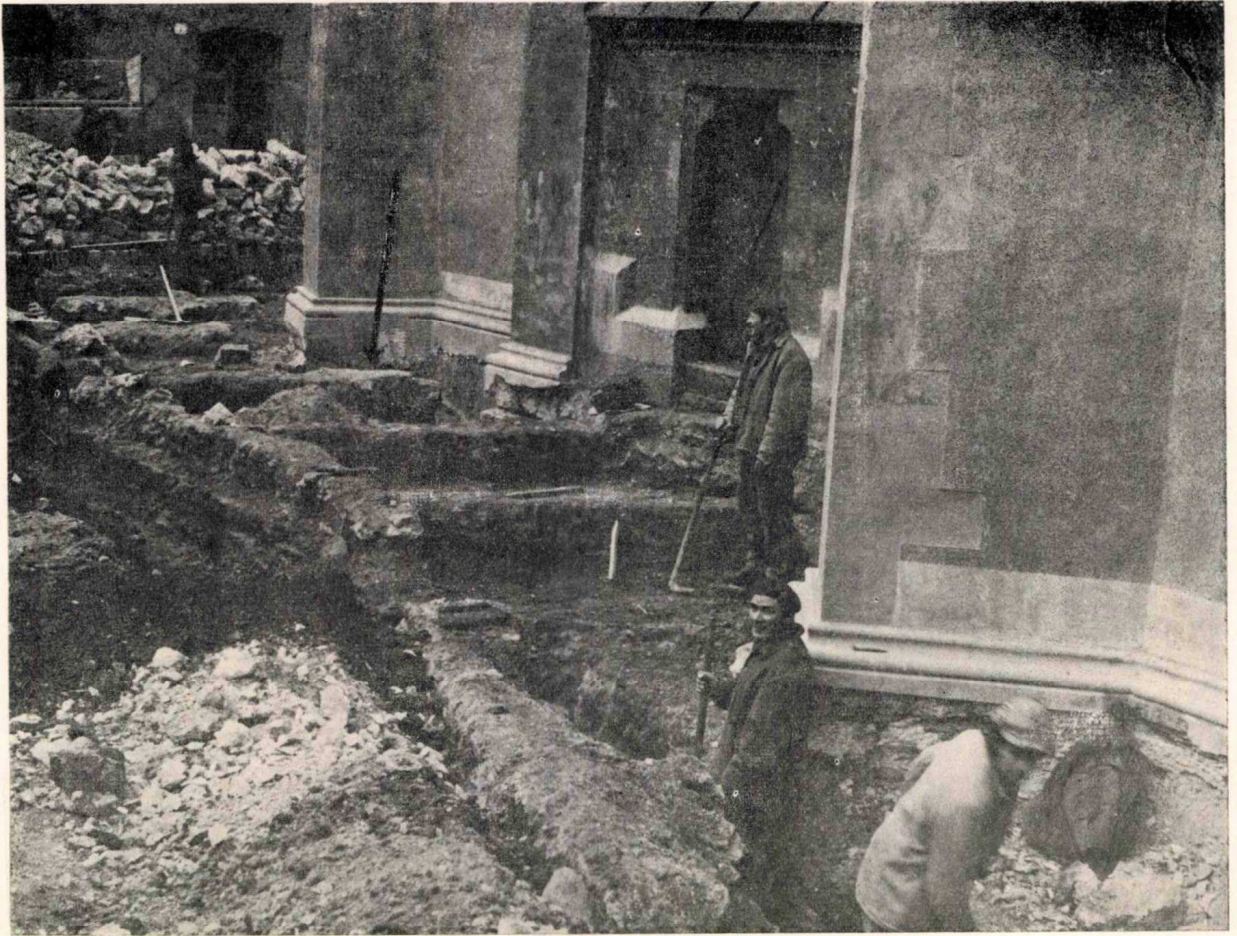
2. A ferences templom mellé épített középkori boltok alapjai (nyíllal jelölve az ötvös bódéja)
